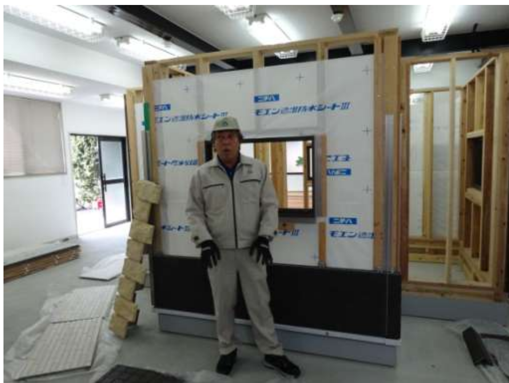
г.Хонма объясняет принцип монтажа нового вида сайдинга «Fuge»
