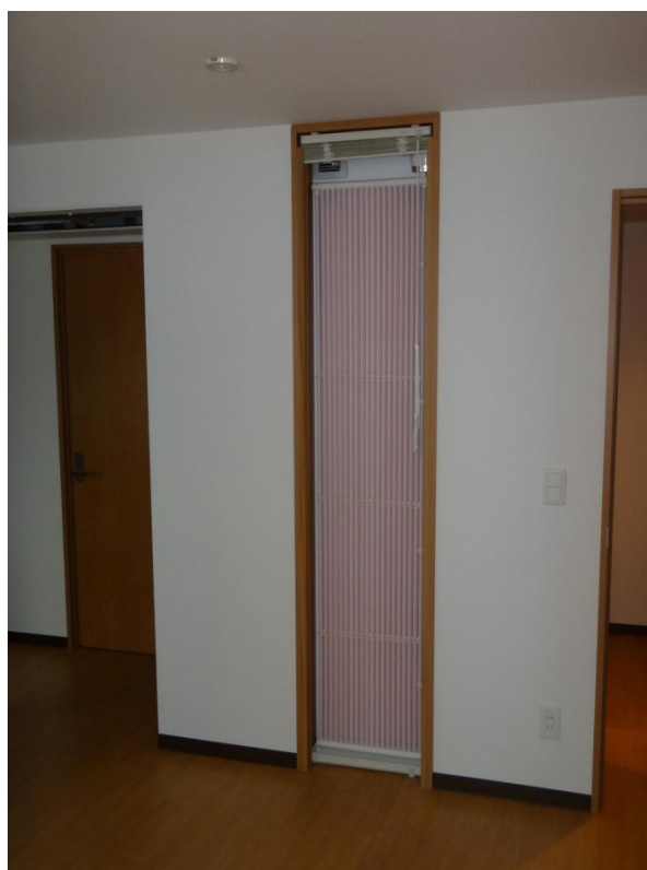
радиатор нового поколения с функциями отопления и охлаждения летом разработанный компанией TESC
