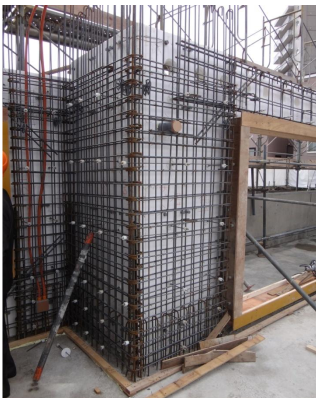
строительство 3-этажного многоквартирного дома по технологии компании TESC
