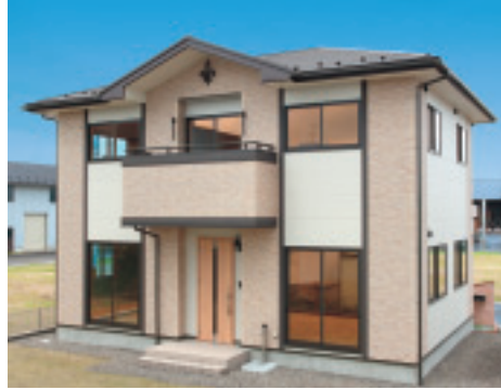
コーナー部分を柱状に張り分け、格調高い仕上がりに。
